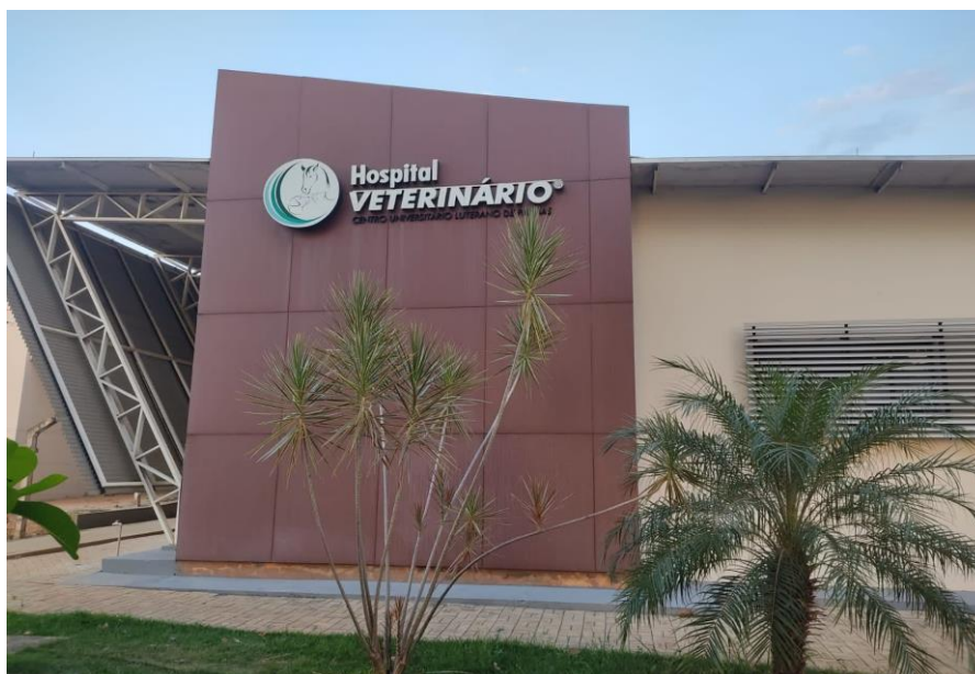
Figura 1. Fachada Hospital Veterinário CEULP/ULBRA, em Palmas - TO
