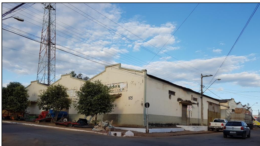
Figura 29: Antigas instalações de empresas beneficiadoras de arroz na Rua Santa Catarina, esquina com a Rua Haroldo Veloso - Maranhão Novo. Autor: Helbaneth Macêdo Oliveira, 2017.
