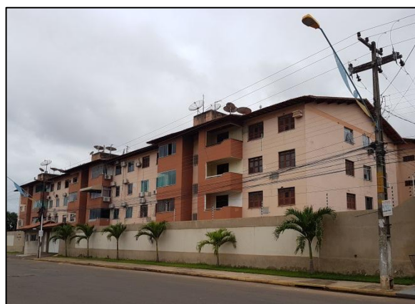
Figura 6: Edifício Minas de Prata localizado na Rua Ceará, nº1600, bairro Nova Imperatriz. Autor: Helbaneth Macêdo Oliveira, 2017.
