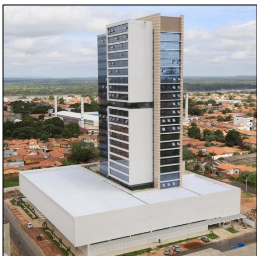
Figura 25: Edifício Aracati Office localizado à Rua Urbano Santos, 115 – Centro. Fonte: http://www.noticiadafoto.com.br . Acesso: 26/04/2017
