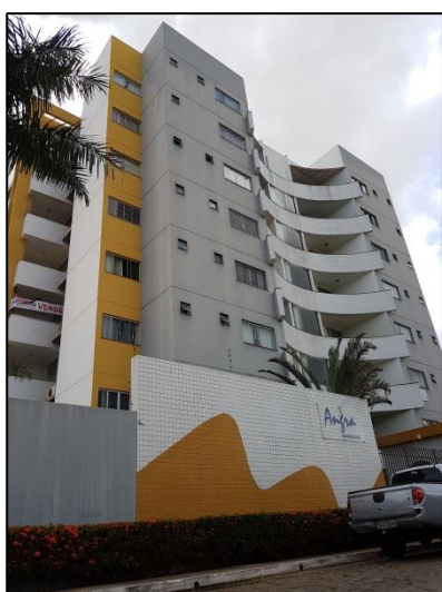
Figura 18: Edifício Angra Residence, Rua Mato Grosso, 26 – Maranhão Novo.
