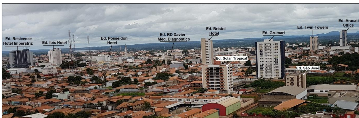
Figura 22: Vista parcial do Centro de Imperatriz com detalhe dos edifícios mais altos. Autor: Helbaneth Macêdo Oliveira, 2017.
