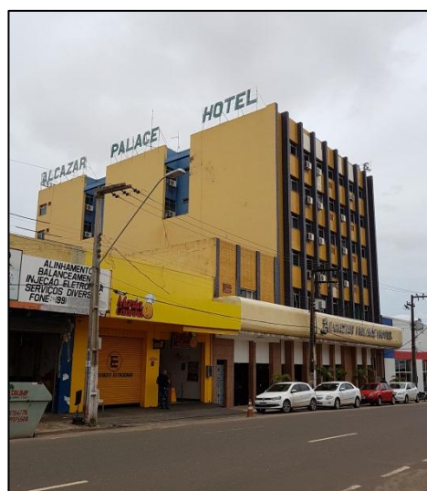
Figura 8: Alcazar Palace Hotel, localizado na Av. Getúlio Vargas, nº2222 bairro Entroncamento. Autor: Helbaneth Macêdo Oliveira, 2017.
