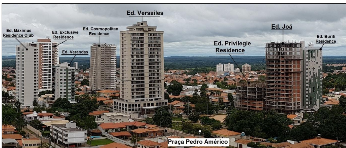
Figura 49: Vista parcial do bairro Jardim Três Poderes, com detalhe da Praça Pedro Américo e dos edifícios localizados em seu entorno. Autor: Helbaneth Macêdo Oliveira, 2017.
