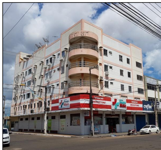
Figura 15: Edifício Ferrama Residencial, edificado pela W. Neto Incorporadora, localizado no Centro.
