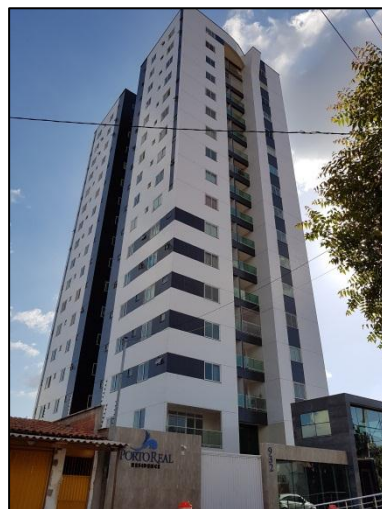
Figura 26: Edifício Porto Real Residence, localizado à Rua 15 de Novembro, 932 – Centro. Autor: Helbaneth Macêdo Oliveira,
