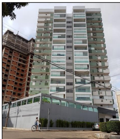
Figura 37: Edifício Grumari localizado na Rua Bahia, 791– Jardim Três Poderes. Autor: Helbaneth Macêdo Oliveira, 2017.
