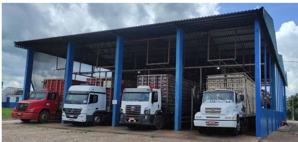
Figura 18 – Galpão de recepção e espera das aves
