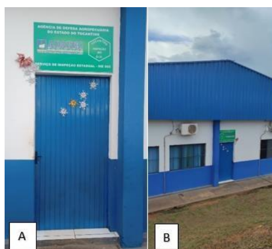
Figura 2 – Bloco do serviço de inspeção estadual.
