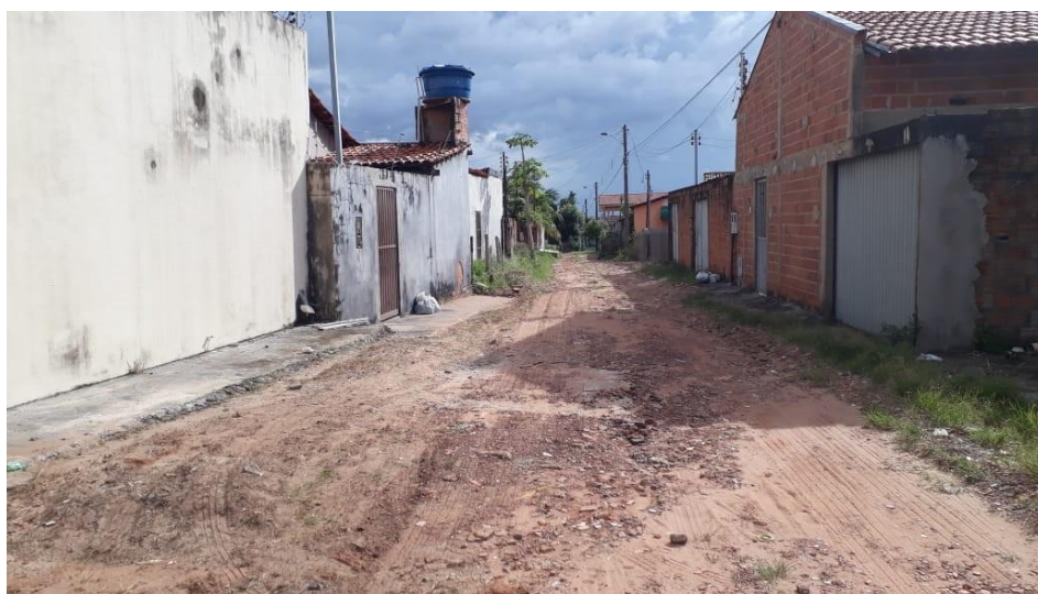
Figura 8C - Rua desprovida de rede esgoto, asfalto e calçamento no São João – sem nome
