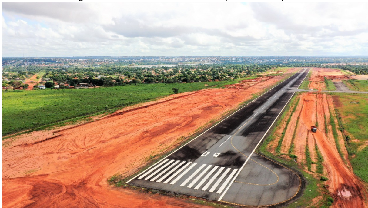
Figura 7 - Reforma na cabeceira da pista do aeroporto
