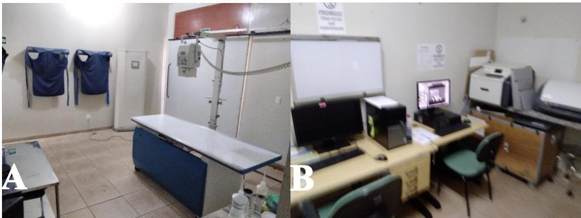
Figura 8. Setor de Radiologia. A, Sala de aquisição radiográfica. B, Sala de laudos.
