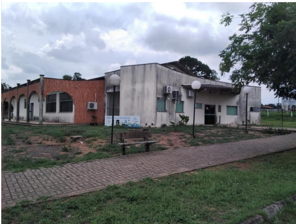
Figura 1. Fachada da Clínica Veterinária Universitária, UFNT Araguaína 2021.
