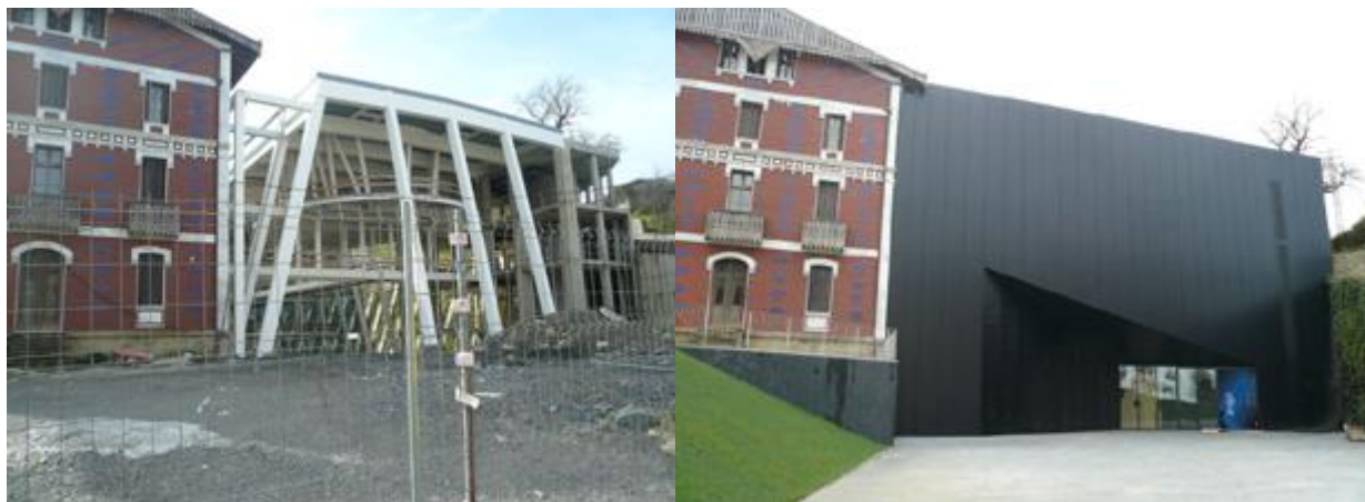
Figura 42– Antes e depois da fachada principal
