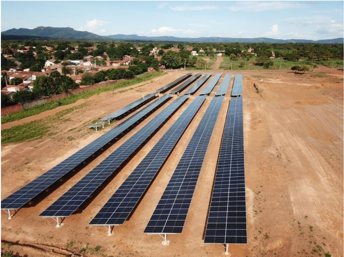
Figura 8 - Resultado final da Infraestrutura da usina fotovoltaica instalada no município de Porto Nacional-TO.
