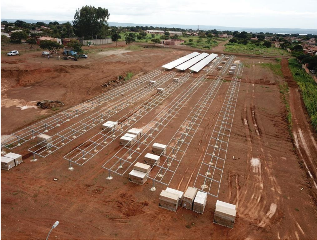
Figura 9 - Material utilizado para colocação dos módulos
