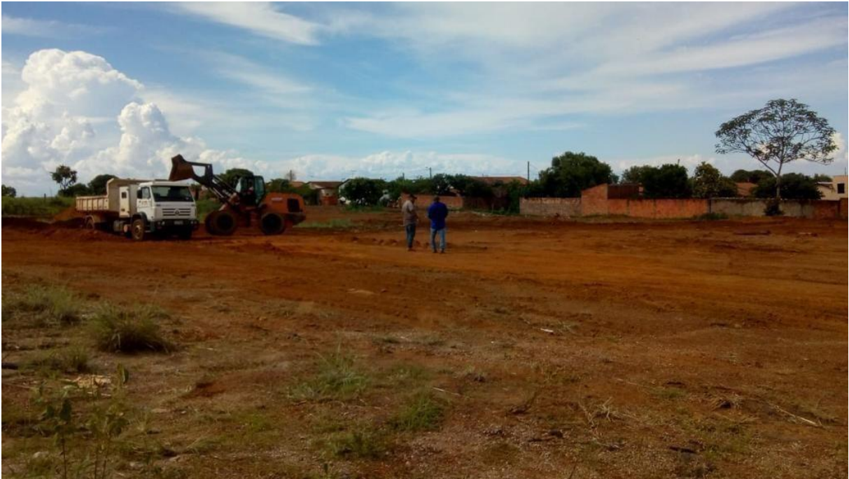
Figura 5 – Limpeza do local de instalação da usina fotovoltaica.
