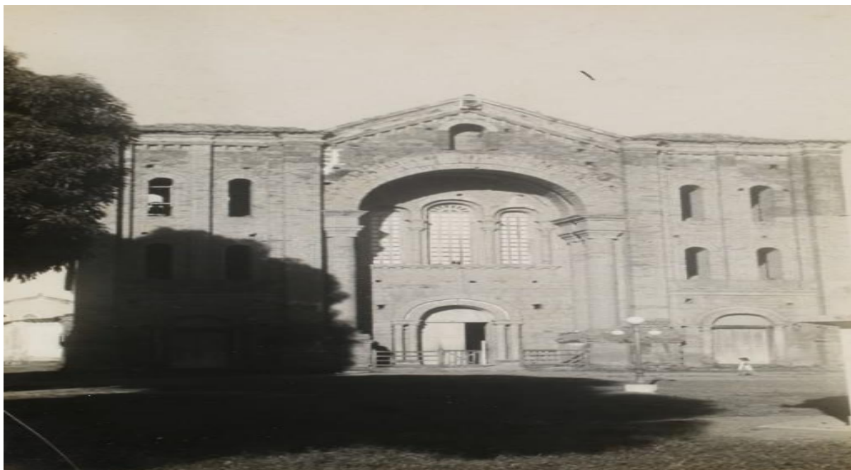
Figura 4- Catedral Nossa Senhora das Mercês antes da inserção dos vidros em algumas janelas
