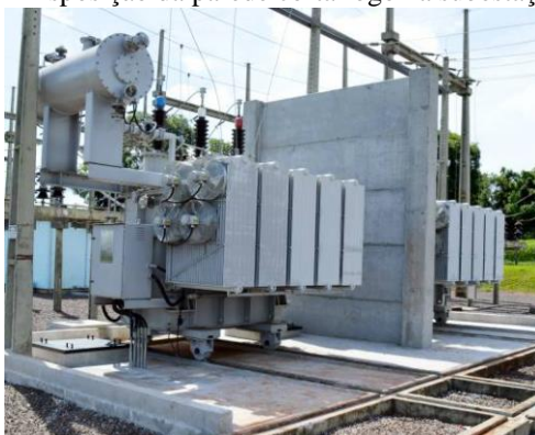
Figura 10 - Disposição da parede corta fogo na subestação
