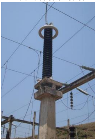
Figura 12 - Para-raios de óxido de Zinco.
