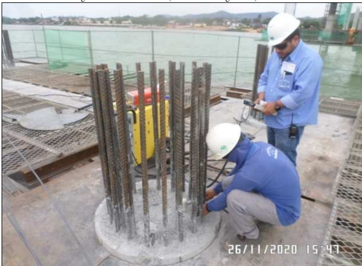
Foto 4: Ensaio de integridade da Estaca – PIT (Protension Integre Test)
