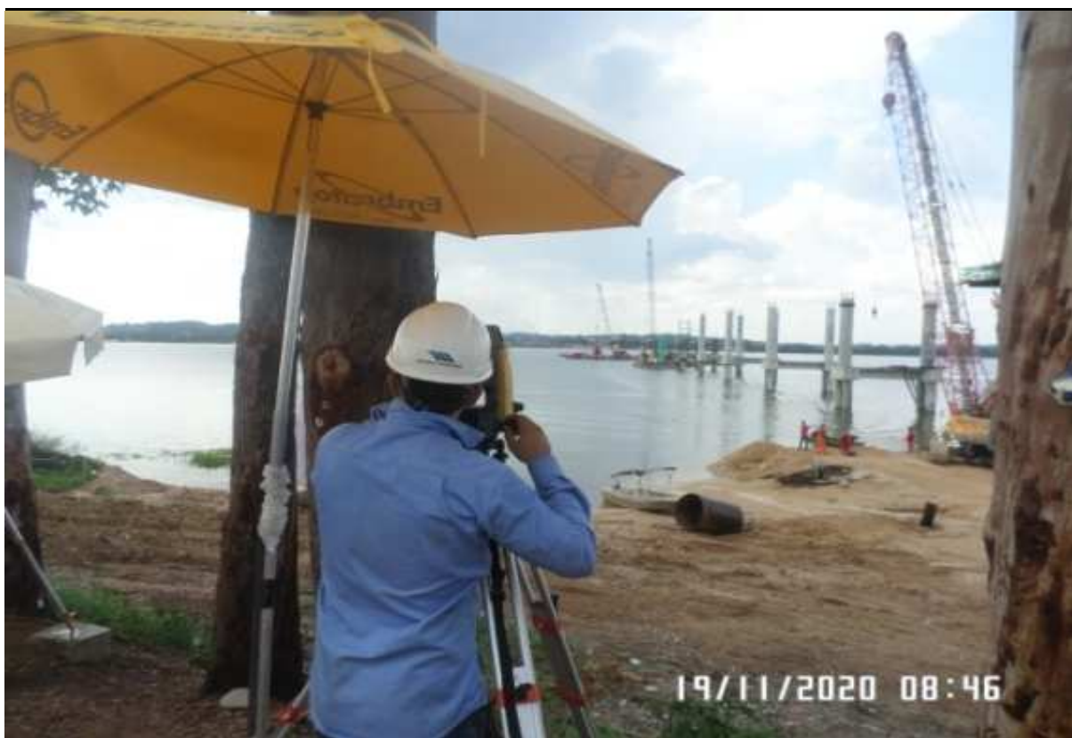
Foto 8 – Verificação das Fundações Especificação de serviço.
