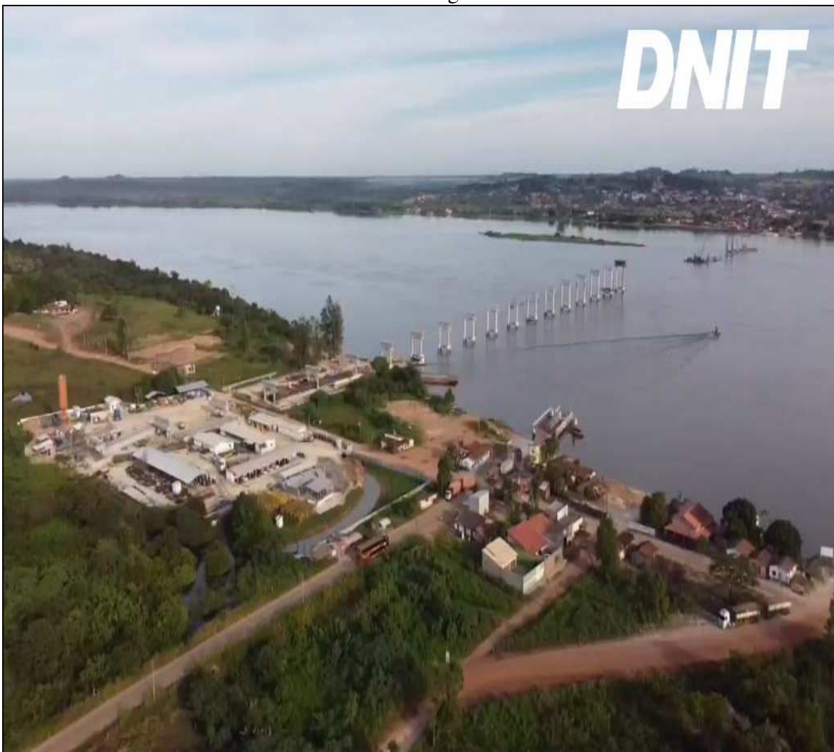
Foto 1: Desenvolvimento da obra sobre o Rio Araguaia vista
