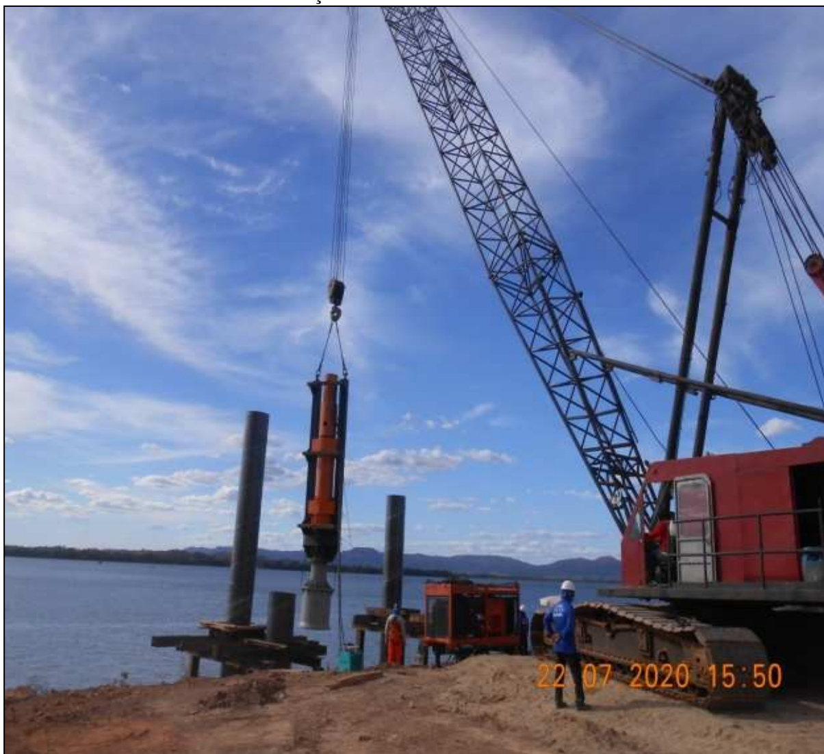
Foto 2: martelo hidráulico de cravação da camisa metálica no solo.
