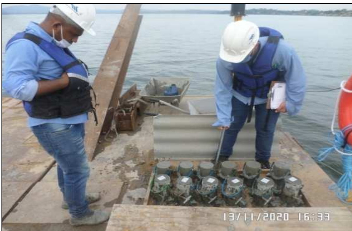
Foto 9 - moldagem e cura de CP's.
