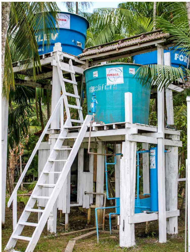
Figura 29 - Solução Alternativa de Tratamento de Água: Montado
