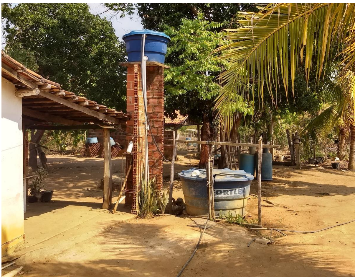
Figura 16 – Reservatório Inferior e Superior: Exemplo
