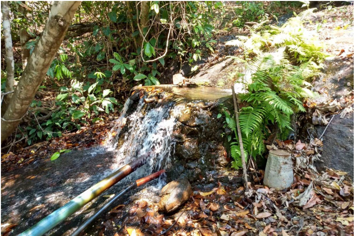
Figura 20 – Captação: Vista Lateral
