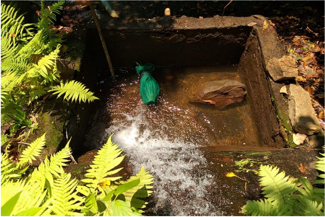
Figura 19 – Captação: Vista Superior
