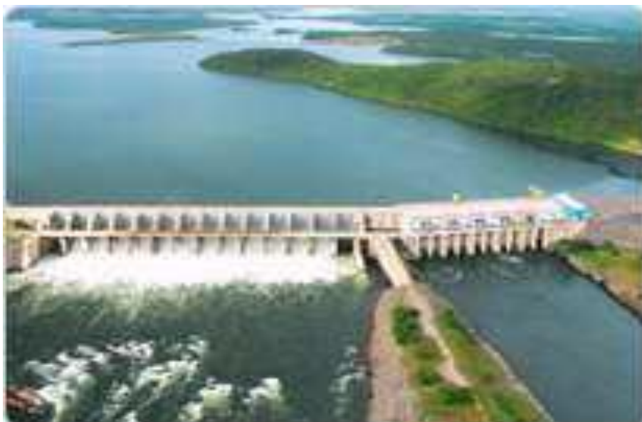
Figura 15: Barragem da Usina do Lajeado
