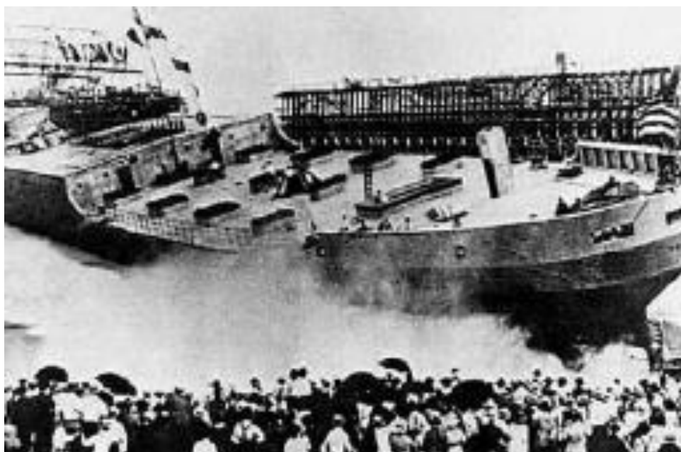
Figura 1 – Embarcação executada em concreto leve
