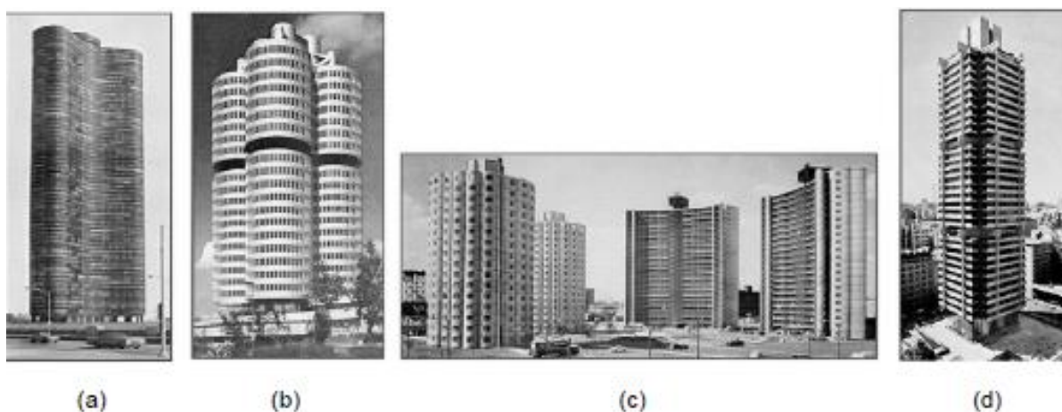
Figura 2 – (a) Lake Point, (b) Edifício administrativo da BMW, (c) Raymond e (d) Standard Bank
