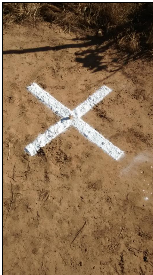
Figura 15. Marcação no terreno com cal hidratada. (Fonte: autor)
