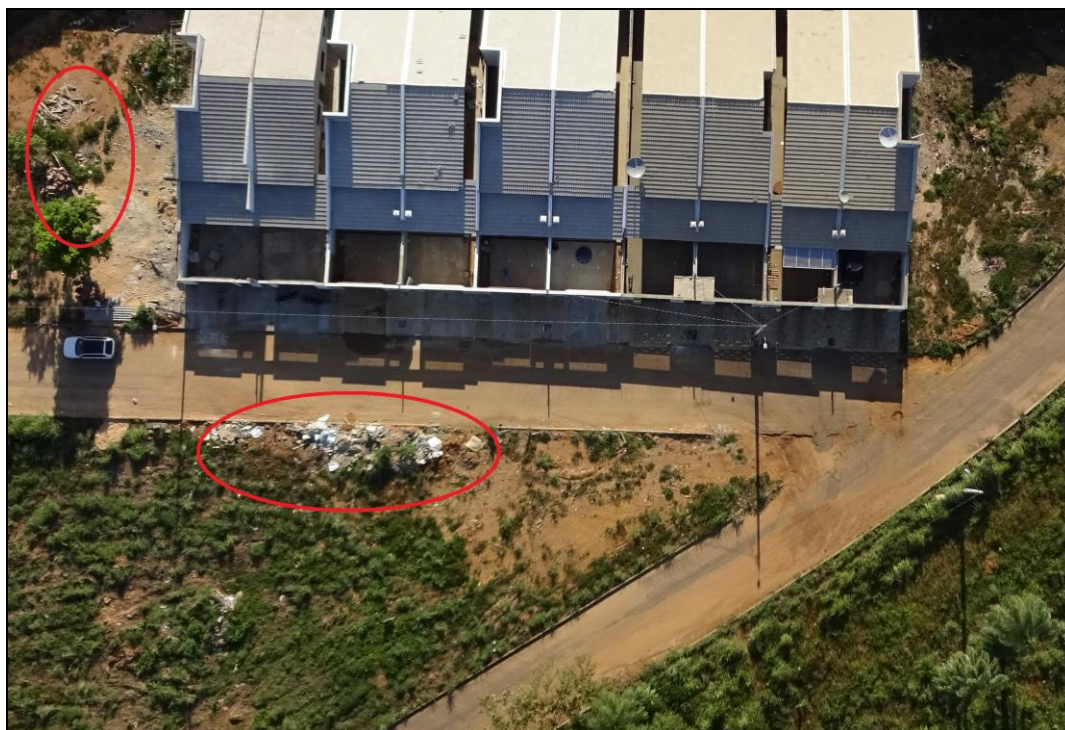
Figura 17. Resíduo de obra em fase de acabamento no setor Berta Ville. (Fonte: autor)
