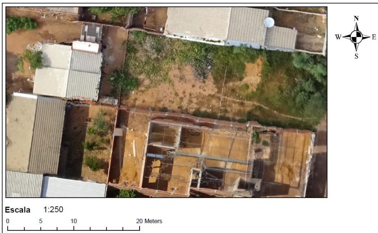
Figura 23. Distorções em arestas e cantos de edificações, nas coordenadas 10^{\circ}21'14,93''\text{S} e 48^{\circ}18'09,37''\text{O} . (Fonte: autor)
