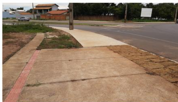
Passarela entre as Avenidas LO-5 e NS-9
