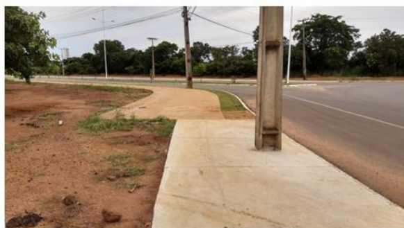
Passarela entre as Avenidas LO-5 e NS-9
