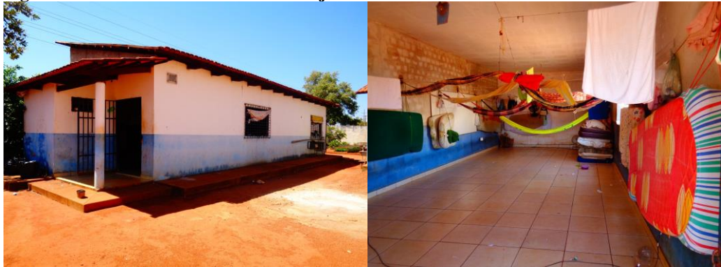
Figura 3- Visão externa e interna do alojamento do semiaberto na CPPPN- out/2016
