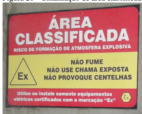
Figura 21 – Sinalização de área classificada
