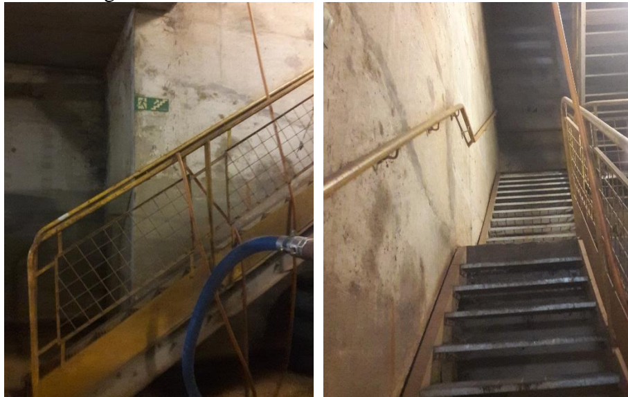
Figura 23 – Escadas no túnel e torre de transferência
