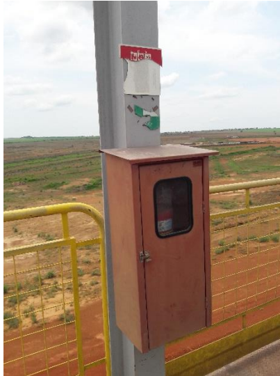
Figura 32 – Sinalização de emergência na tulha
