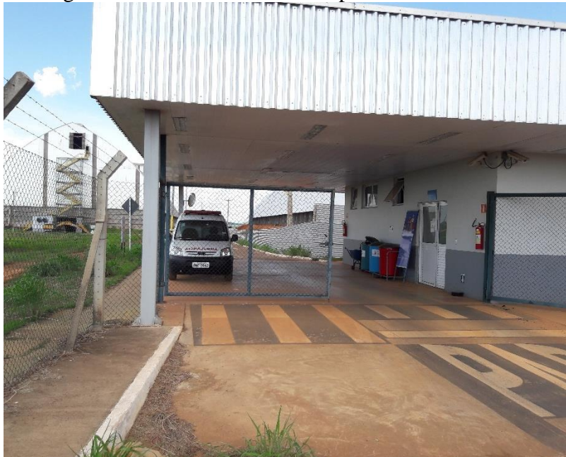
Figura 47 – Portão de acesso do prédio administrativo
