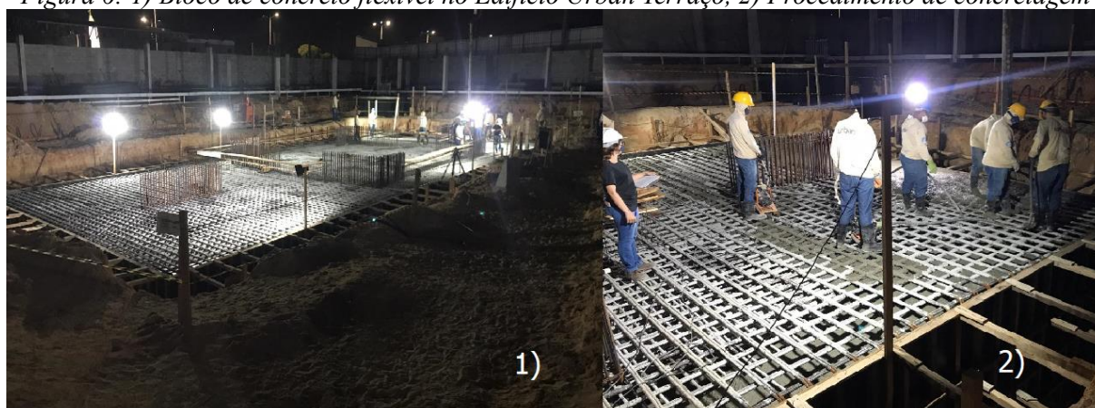
Figura 6: 1) Bloco de concreto flexível no Edifício Urban Terraço, 2) Procedimento de concretagem
