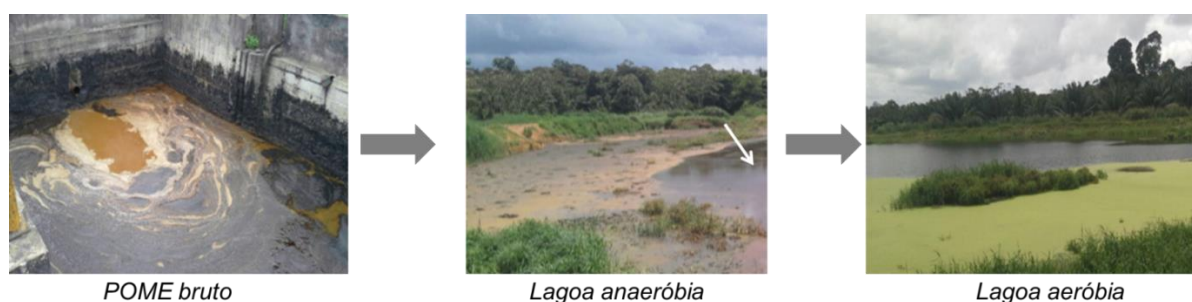
Figura 6 – Lagoas de estabilização de POME na agroindústria Denpasa (Santo Antônio do Tauá/PA). A seta branca indica o ponto de coleta do ELE-POME na saída da lagoa anaeróbia de estabilização de POME. Fonte: Bruno Brasil (acervo pessoal).
