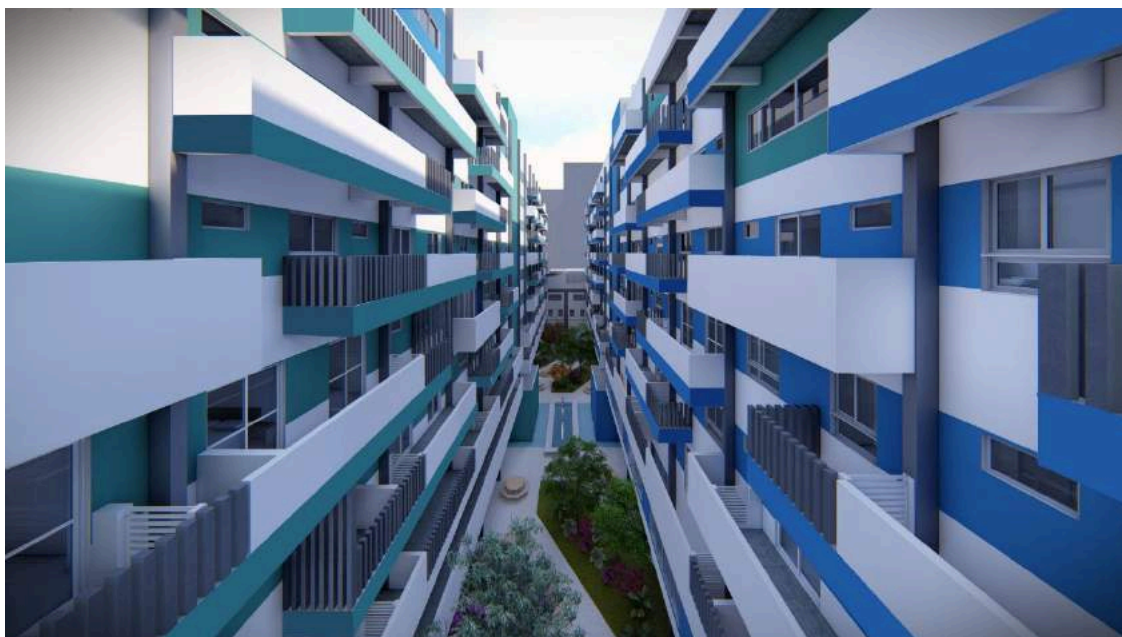
Figura 118 – Pátio Interno e fachadas
