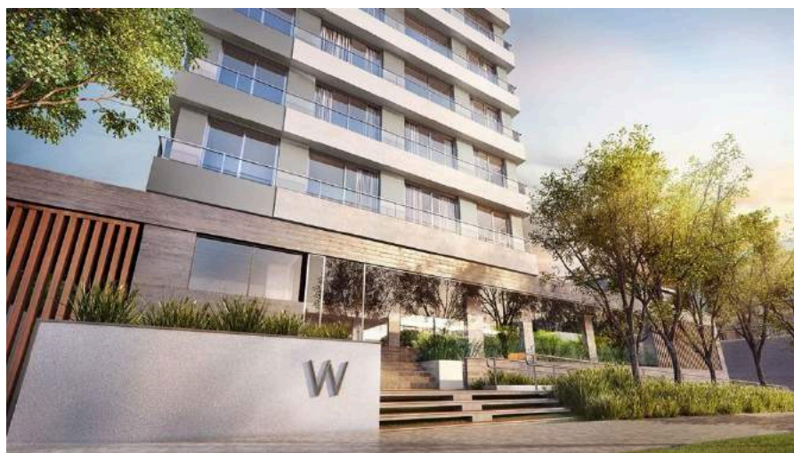
Figura 48 – Acesso principal torres comerciais e seu caráter privativo – Edifício W
