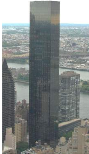
Figura 19 – Edifício Trump World Tower (Nova York, Estados Unidos)
