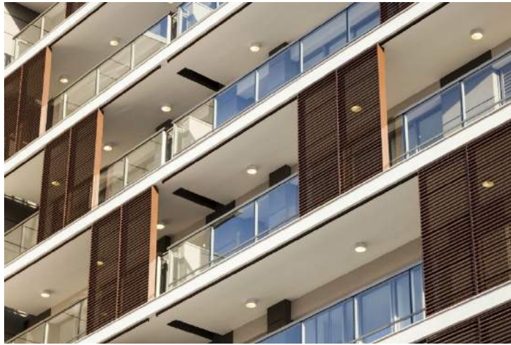
Figura 41 – Brises móveis da fachada – Edifício Meet
