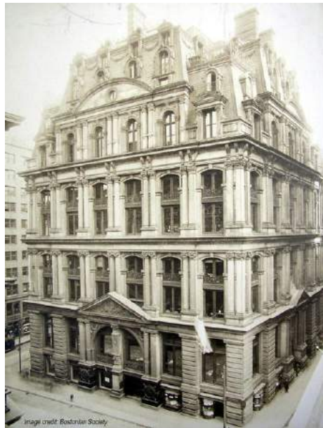
Figura 16 – Edifício Equitable Life Assurance Society (Nova York, Estados Unidos)
