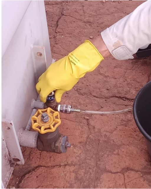
Figura 10 – Conexão da mangueira ao registro inferior
