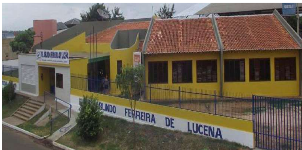
Figura 1: Visão panorâmica do C E Arlindo Ferreira de Lucena com a fachada principal da escola em primeiro plano e uma parte lateral do prédio
