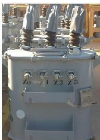
Figura 12 - Invólucro para proteção da bucha de alta tensão.
