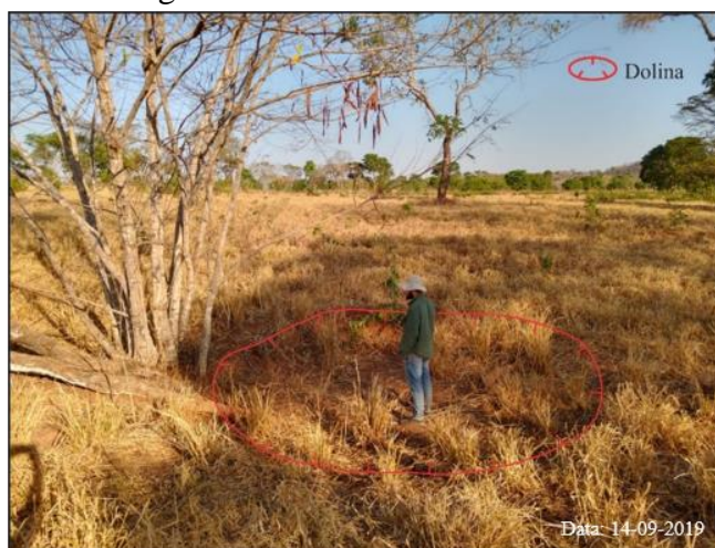
Figura 35 – Dolina de subsidência.
