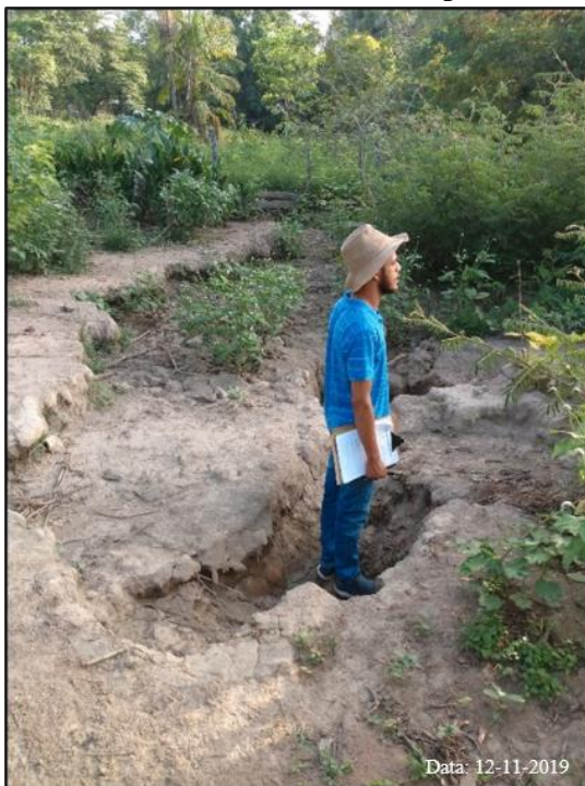
Figura 20 – Sumidouro no interior de depressão escalonada.
