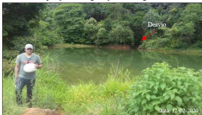
Figura 38 – Barramento no interior do polje : lâmina d’água em primeiro plano, desvio para captação e vegetação no segundo.
