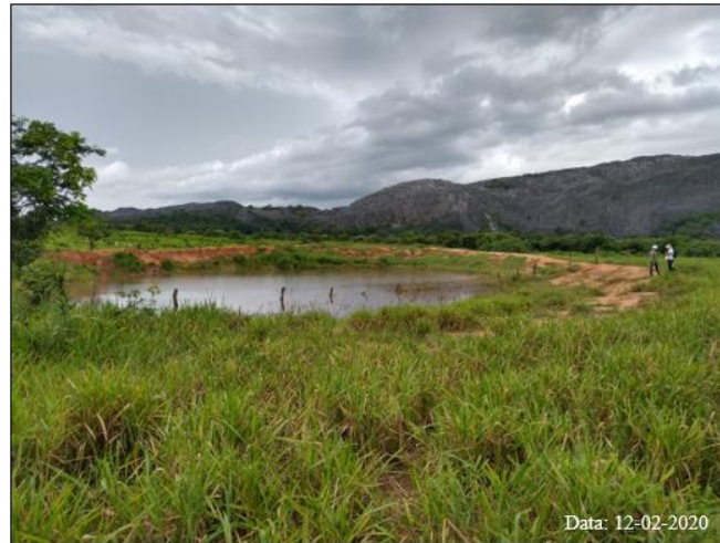
Figura 39 – Barramento no interior do polje : pastagem em primeiro plano, barramento em segundo e Morro da Oficina ao fundo.
