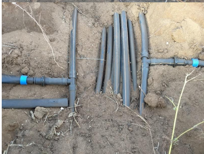
RFE 40 – TUBO CEGO PE 16012 - 400M, com detalhe do CONECTOR TE DENTADO 17 X 17 X 17 e CONECTOR UNIAO TYPHOONXTYPHOON- UNIVERSAL.
