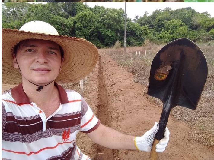
RFE 10 – Escavação manual a 0,30 m de profundidade, para posicionamento do tubo gotejador DRIPNET PC™ AS 16150.
