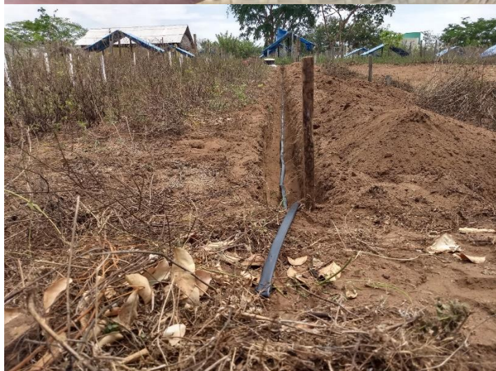
RFE 16 – Escavação manual a 0,30 m de profundidade, para posicionamento do tubo gotejador DRIPNET PC™ AS 16150.
