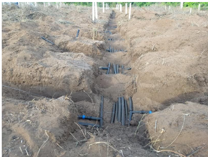
RFE 39 – TUBO CEGO PE 16012 - 400M, com detalhe do CONECTOR TE DENTADO 17 X 17 X 17 e CONECTOR UNIAO TYPHOONXTYPHOON- UNIVERSAL.
