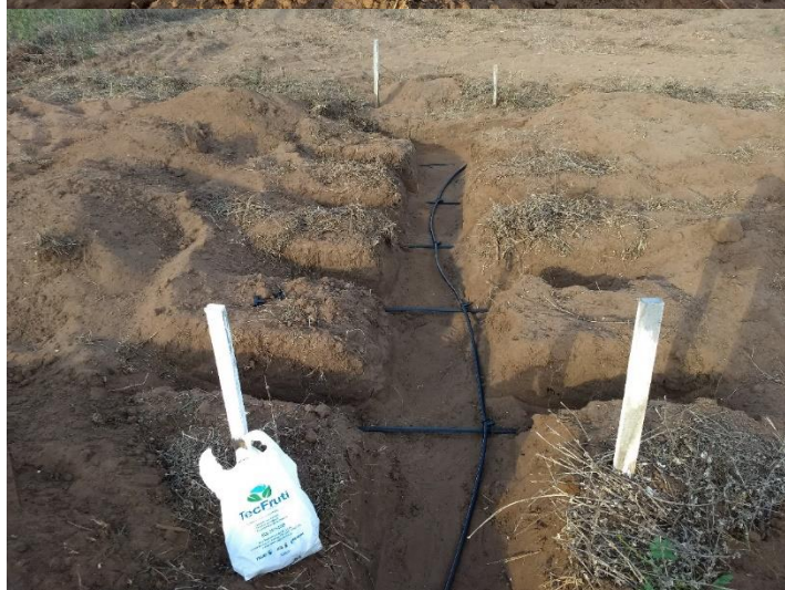
RFE 37 – TUBO CEGO PE 16012 - 400M com detalhe do CONECTOR TE DENTADO 17 X 17.
