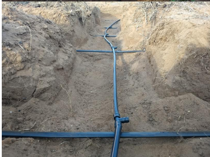
RFE 38 – TUBO CEGO PE 16012 - 400M com detalhe do CONECTOR TE DENTADO 17 X 17.
