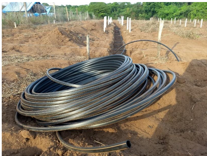
RFE 36 – Linha ramal e secundaria com TUBO CEGO PE 16012 - 400M.
