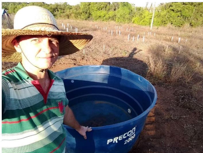
RFE 6 – Instalação da caixa de água de 2.000 L, para sucção do sistema de irrigação (período seco).
