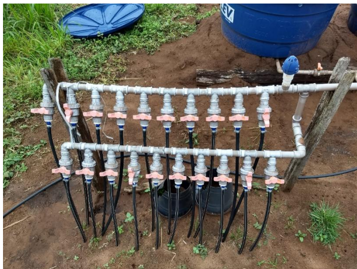
RFE 33 – CAVALETE com REGISTRO ESFERA PVC VS 32”.
