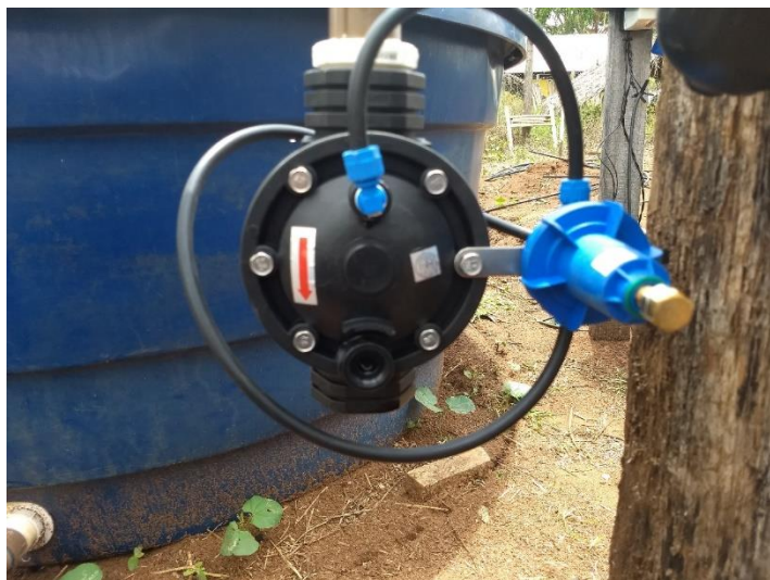
RFE 27 – Válvula para alívio da pressão DOROT VALV PLAS 75-1" BASICA-BSP com DOROT PILOTO PLASTICO 29-200/54 8MM.
