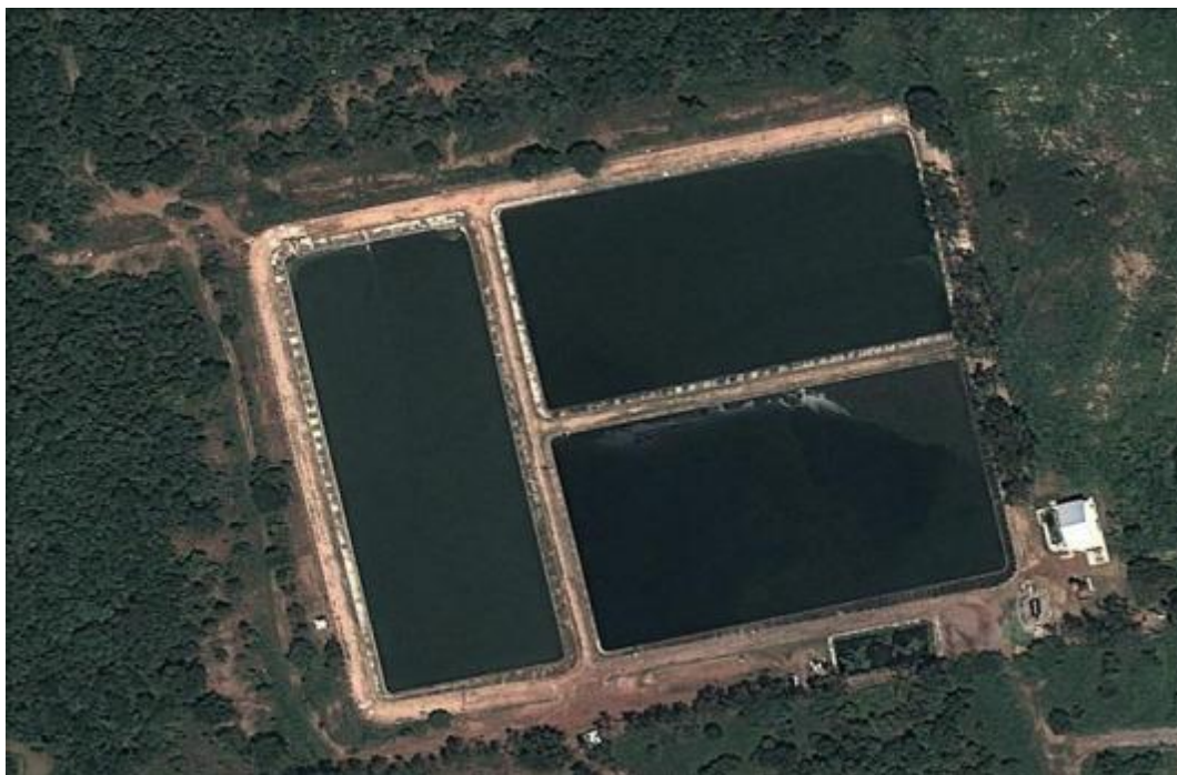
Figura 2. Vista aérea da ETE Aurenny (Fonte: Google Earth, 2016).
