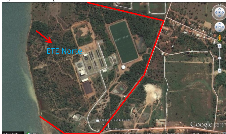
Figura 17: Visão panorâmica da ETE Norte, Palmas-TO
