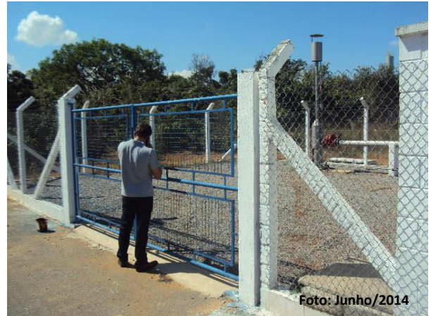
Foto 02: Portão de acesso aos queimadores de gás.
