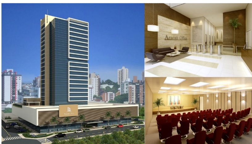
FIGURA 17: Aracati Office, condomínio de salas comerciais e escritórios em Imperatriz/MA. Fonte: Aracati Construções – responsável pelo empreendimento.
