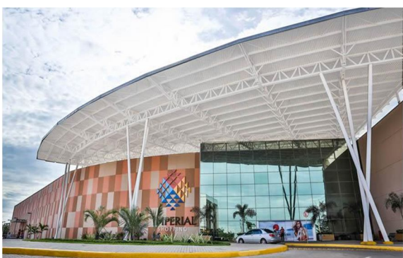
FIGURA 15: Fachada do Imperial Shopping em Imperatriz/MA. Fonte: pesquisa de campo. Foto: elaboração própria.
