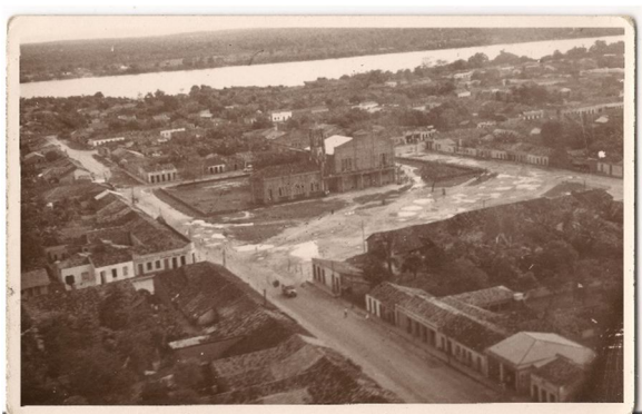
FIGURA 18: Construção da Praça de Fátima entre as Avenidas Dorgival Pinheiro de Sousa e Getúlio Vargas, nos anos 1960 - Imperatriz/MA. Foto: Albé Ambrogio.
