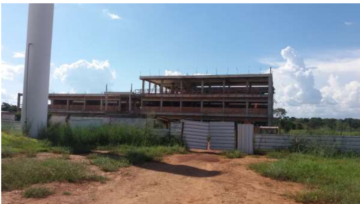
FOTO 11: COMPLEXO TRÊS PAVIMENTOS GURUPI
