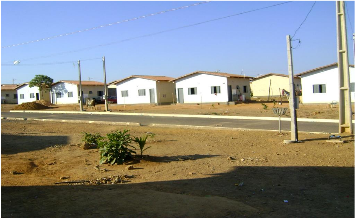
Figura 14 - Vista de uma das ruas do empreendimento Morada do Vale
