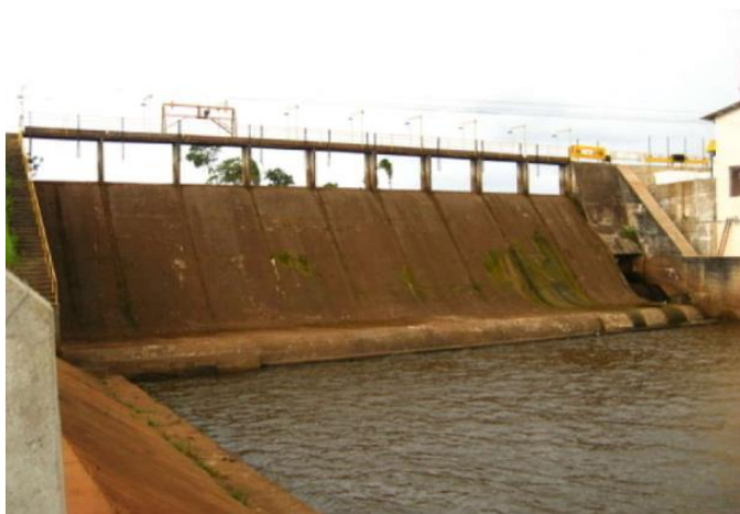
Figura 6: Barragem da CGH Corujão
