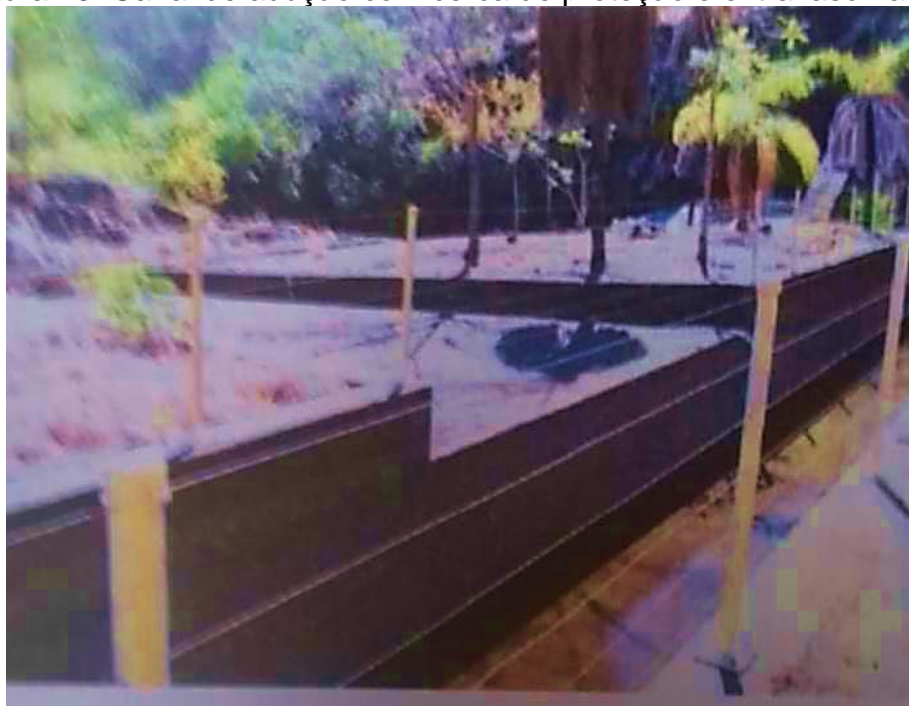
Figura 13: Canal de adução com cerca de proteção e extravasor lateral
