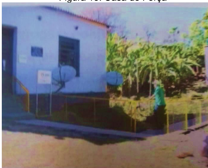
Figura 19: Casa de Força
