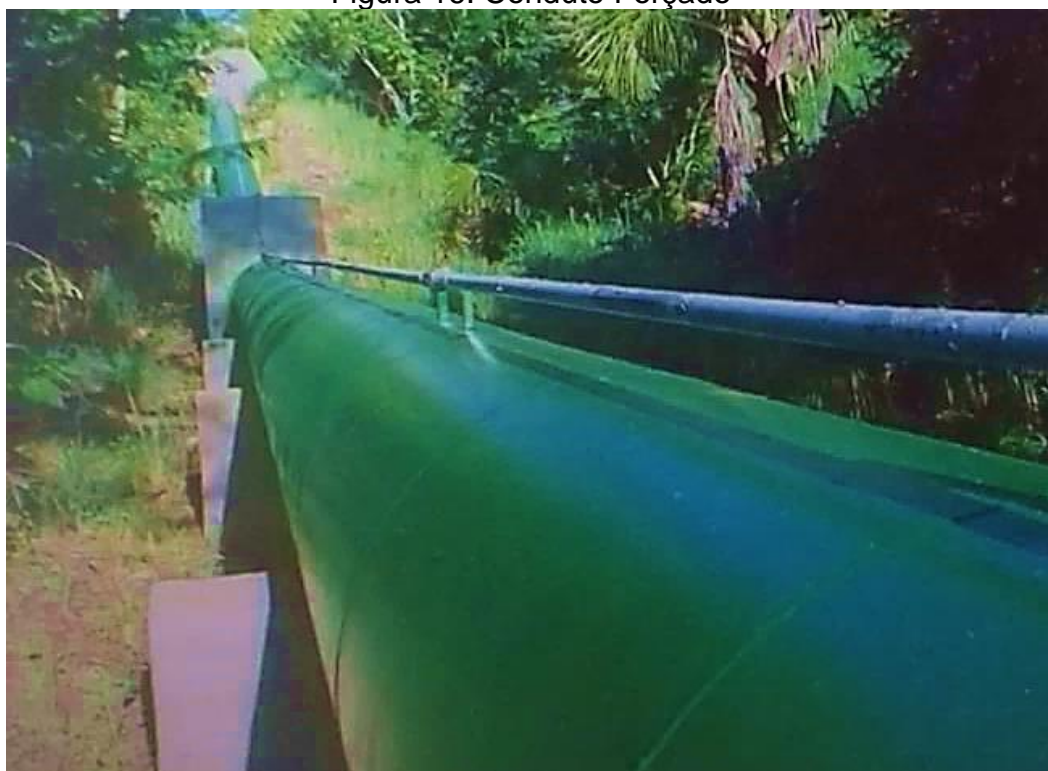
Figura 16: Conduto Forçado
