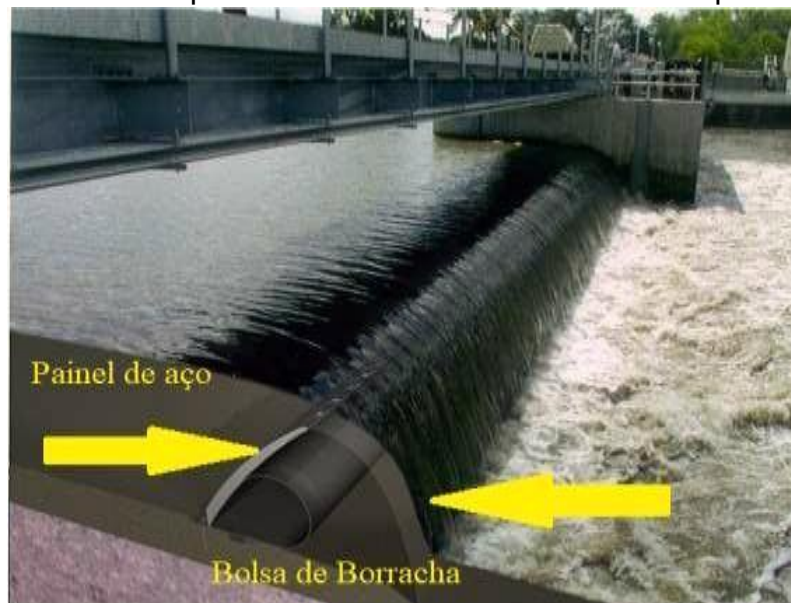
Figura 5: Vista esquemática de uma bolsa inflável com placas de aço
