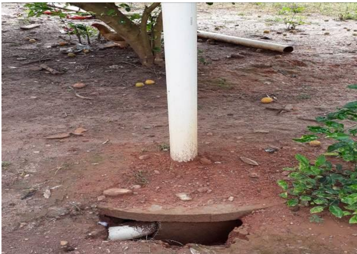
Figura 13. Exemplar de fossa em uma propriedade no Projeto de Assentamento Manoel Alves no município de Araguaína - TO.
