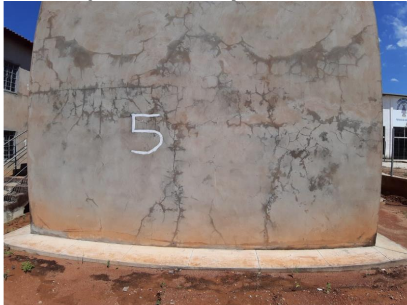
Figura 19 – Fissuras Mapeadas/Fachadas
