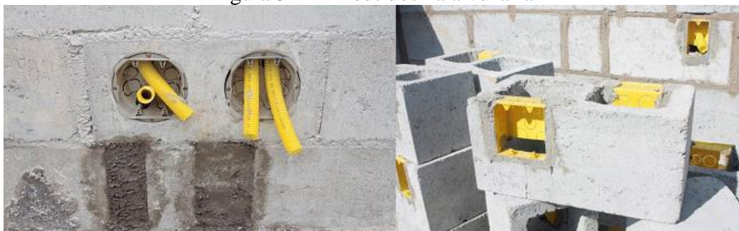
Figura 31 – Embutidos na alvenaria
