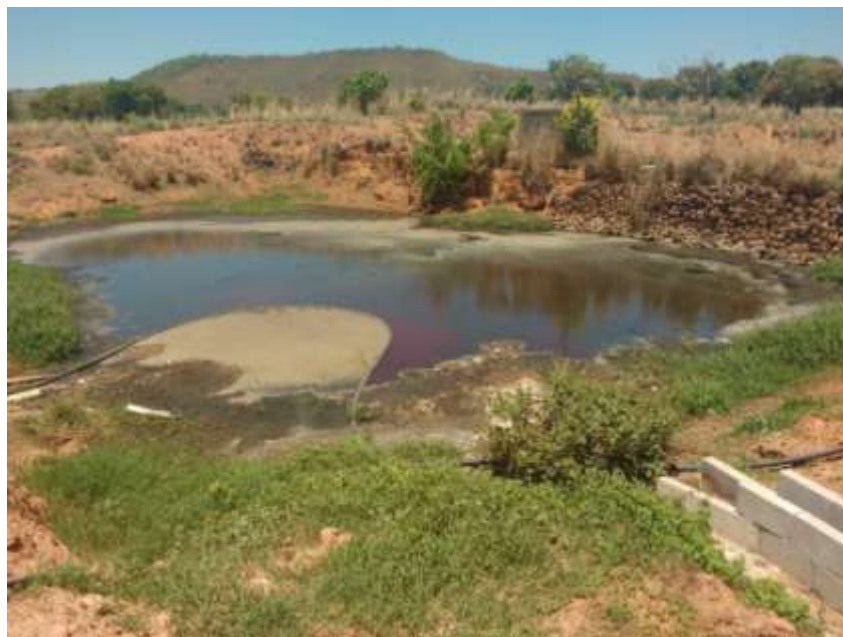
Figura 09. Lagoa de decantação
