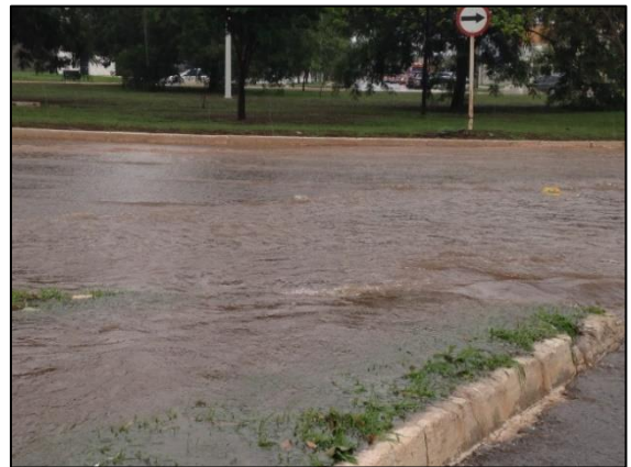
Figura 12. Canteiro central em frente a rotatória da Av. NS-4 com a Av. LO-25
