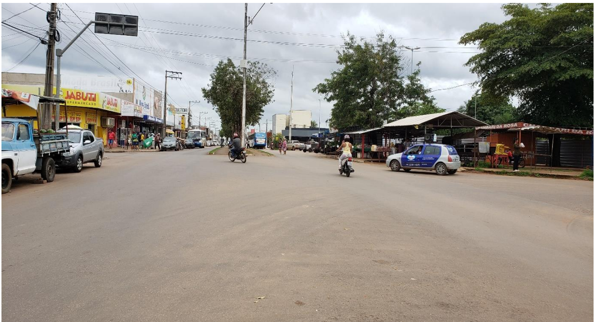
Figura 21 - Cruzamento da Av. Tocantins e Av. Taquaruçu em Taquaralto - Centro
