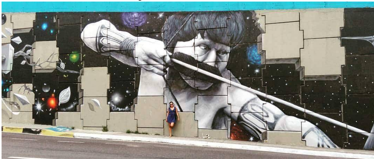
Figura 48. O Viaduto do Coroado.
