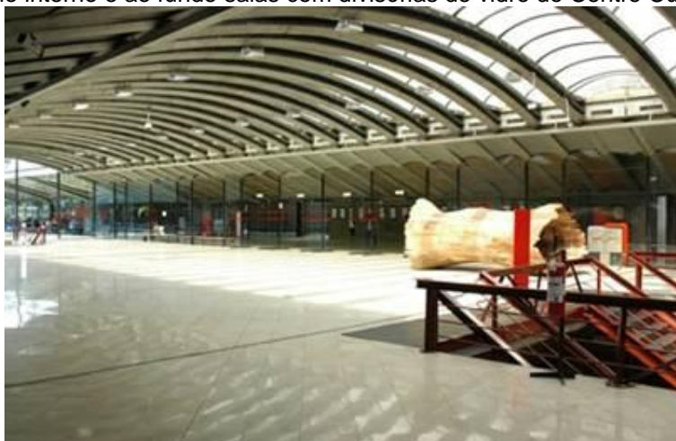
Figura 16– Pátio interno e ao fundo salas com divisórias de vidro do Centro Cultural São Paulo
