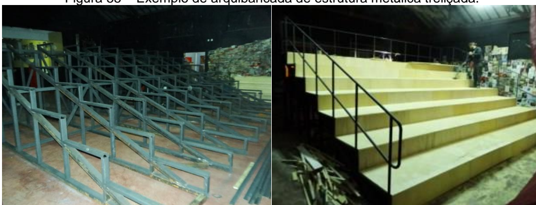
Figura 55 – Exemplo de arquibancada de estrutura metálica treliçada.
