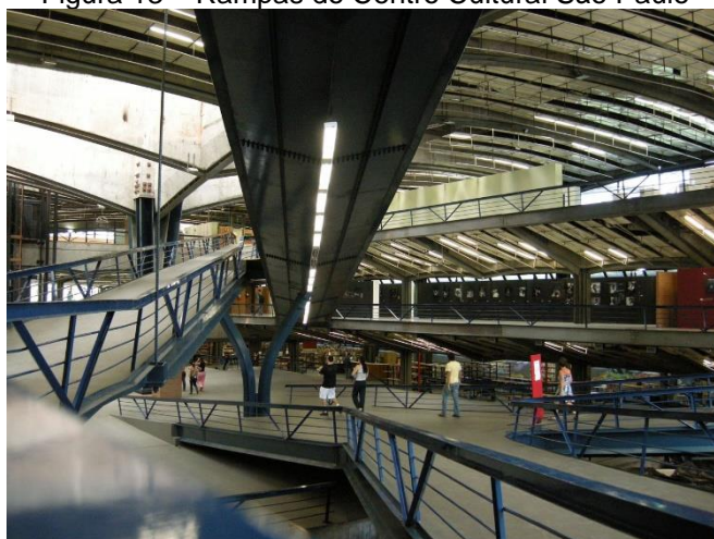
Figura 13 – Rampas do Centro Cultural São Paulo
