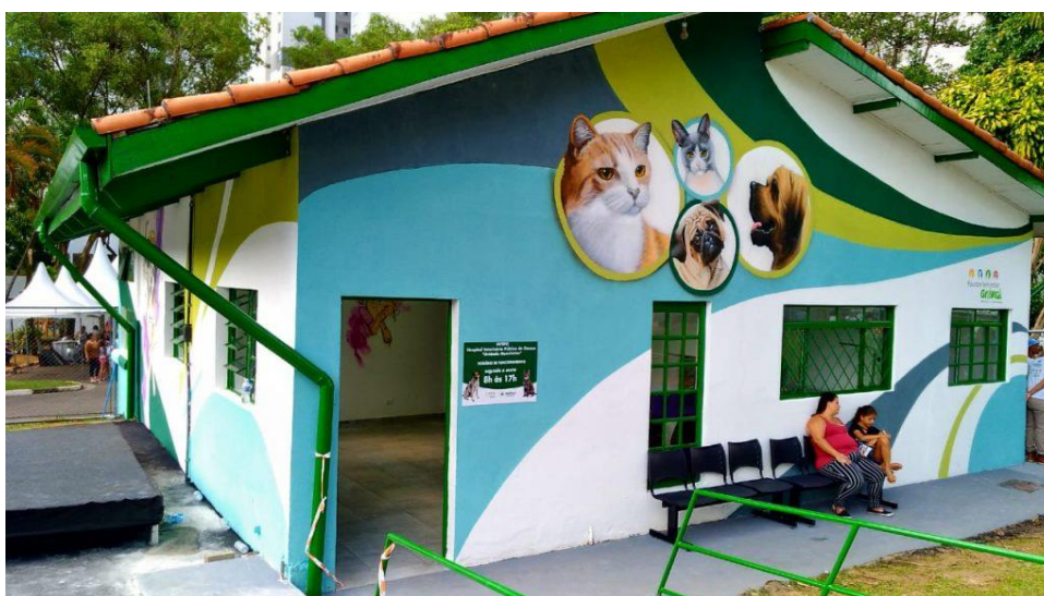
Figura 26 - Fachada principal Hospital Veterinário Manchinha
