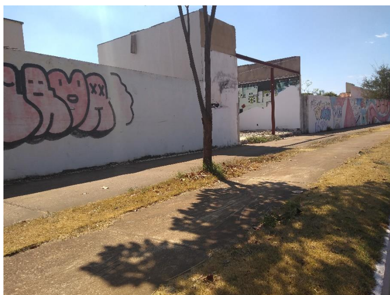
Figura 52 - Trecho de calçada na via NS-04
