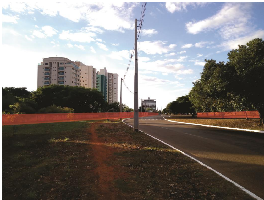
Figura 40 - Imagem de muros em um trecho da NS-06
