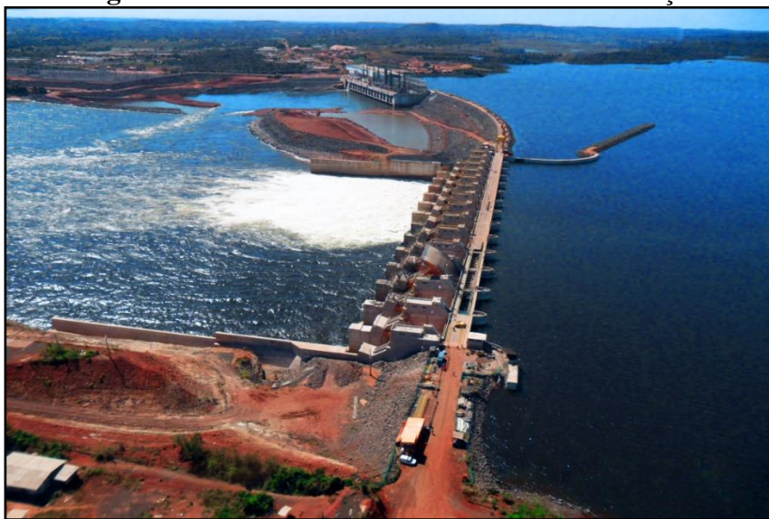
Figura nº 1: UHE/Estreito em sua fase de construção
