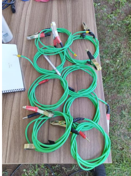
Figura 31 - Cabos de conexão
