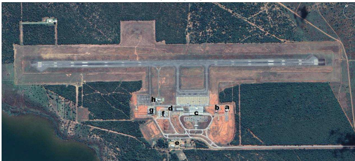
Figura 2 - Edificações do Aeroporto Brigadeiro Lysias Rodrigues, Palmas/TO.
