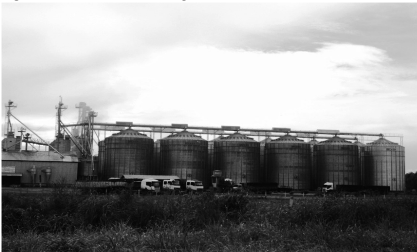
Figura 23 – Armazéns em Lagoa da Confusão
