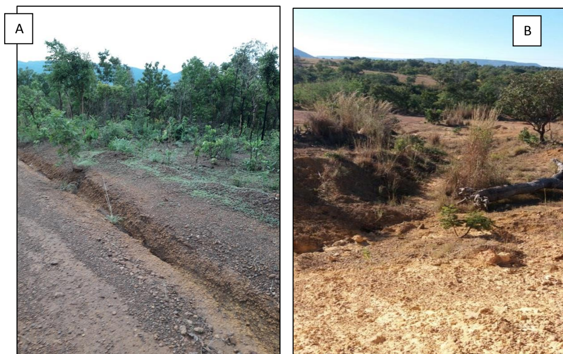
Figura 25 – Solo exposto e degradação ambiental pela supressão da vegetação surgindo ravinas junto a estrada de terra (A) e em área de empréstimo (B)
