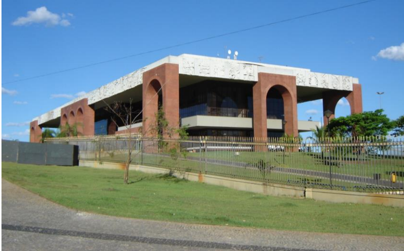
Figura 46 – Palácio Araguaia em Perspectiva Contraplongê
