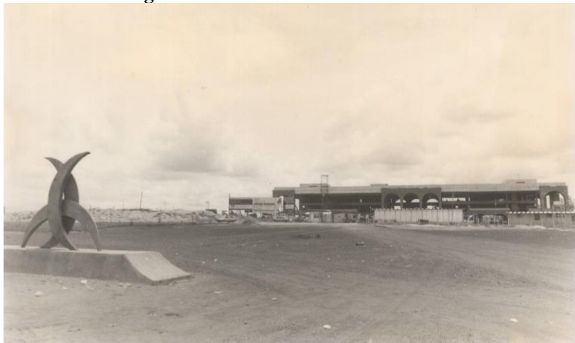
Figura 52 – Monumento à Lua Crescente
