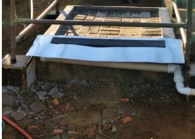
Figura 16. Detalhe da calha coletora do escoamento superficial.
