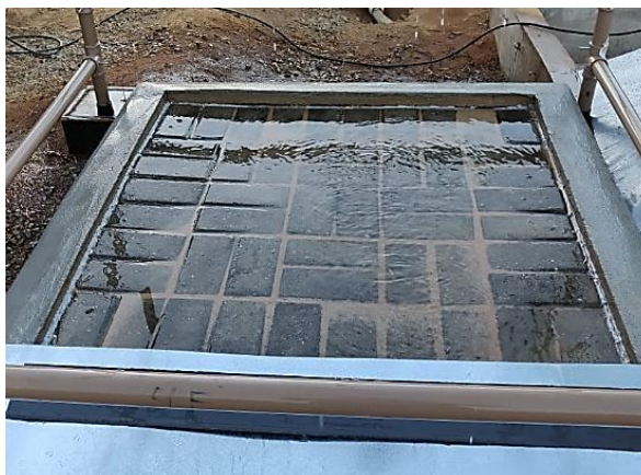
Figura 29. Lâmina de água sobre o BM.
