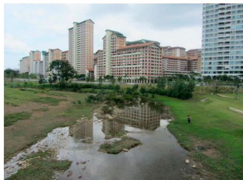
Figura 39: Bishan Park plan, inserido no Plano de Utilidades Públicas: primeiro projeto de bioengenharia a converter um canal de concreto de volta a um rio, em Cingapura
