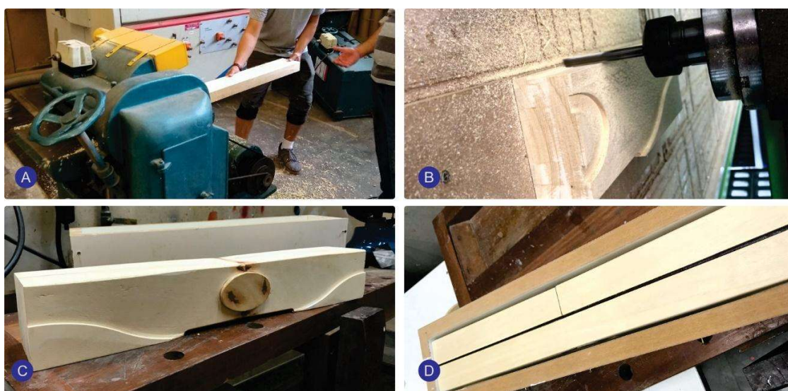
Figura 145: Fabricação digital do molde da estrutura
